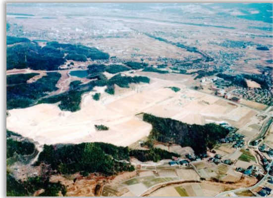
造成工事終了直後の田辺用地 1984年
