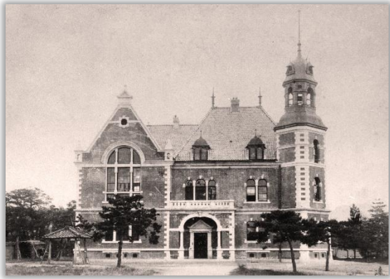
竣工当時のクラーク神学館
