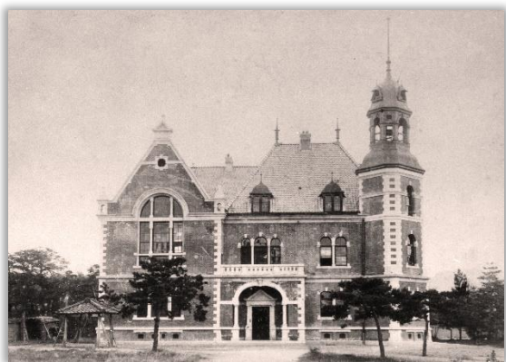
竣工当時のクラーク神学館
