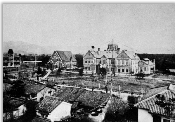
竣工時のハリス理化学館
