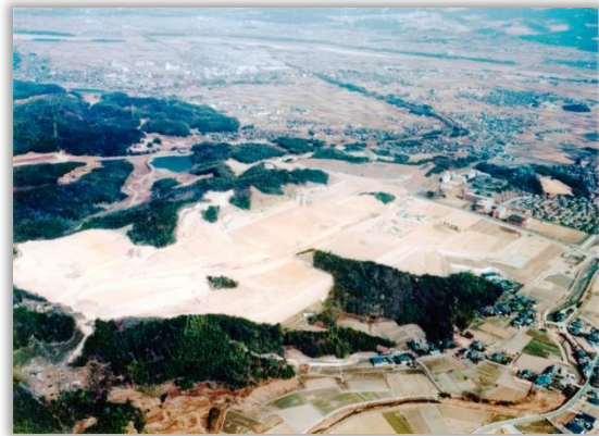
造成工事終了直後の田辺用地 1984年
